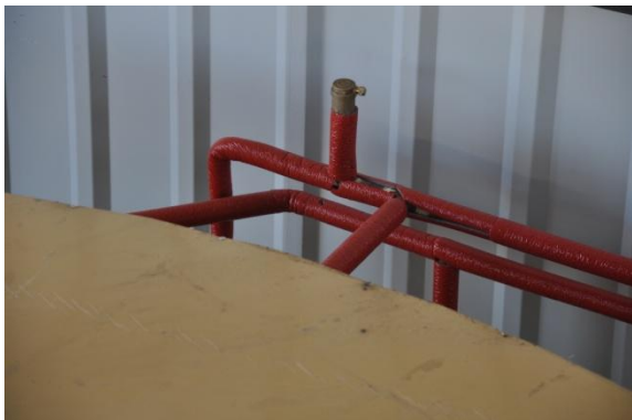
Doprowadzenie ciepłej wody
