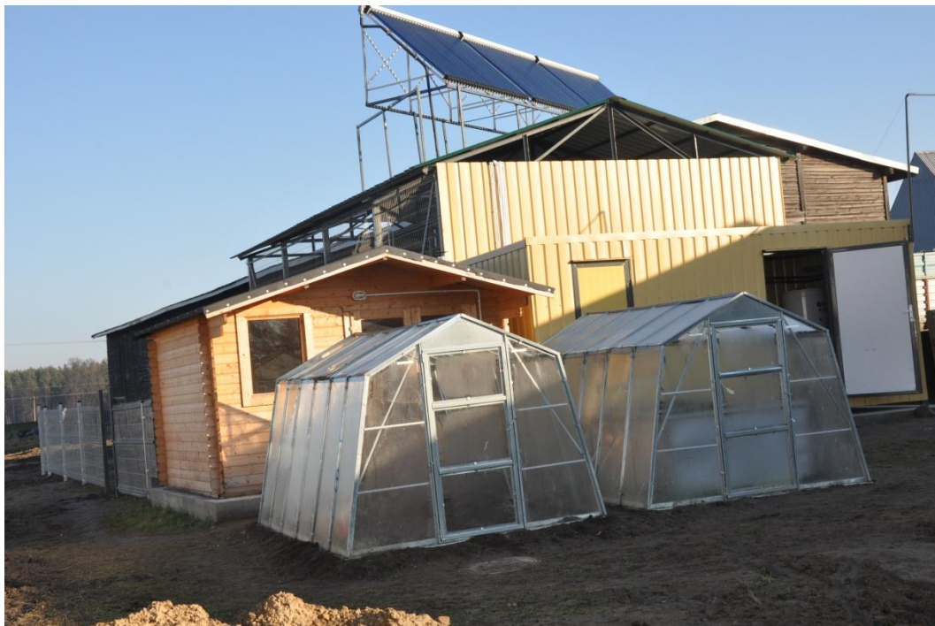
Pilotowa Biogazownia Rolnicza
