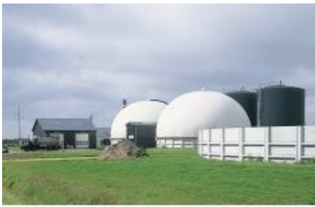
Blabjerg biogas plant, Denmark
