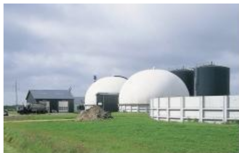
Blabjerg biogas plant, Denmark
