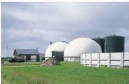
Blabjerg biogas plant, Denmark
