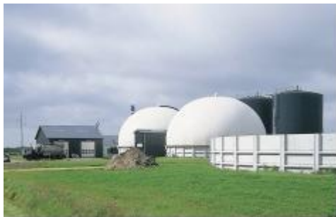
Blabjerg biogas plant, Denmark
