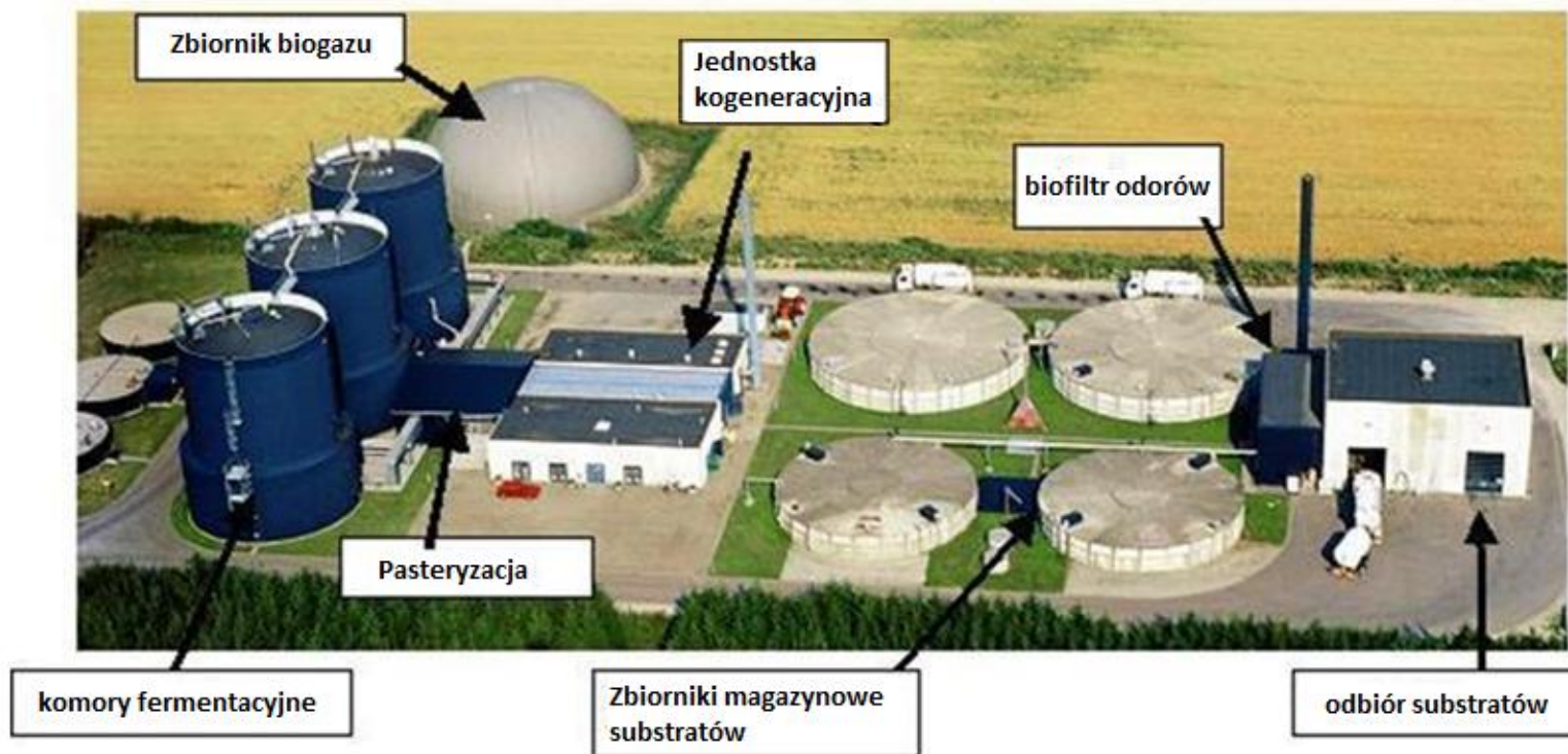
Instalacja biogazowa w Lemvig (Dania) 2,5 MW
