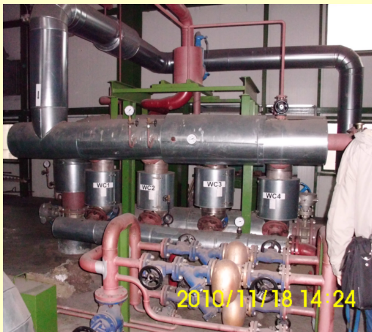
Węzeł ciepłowniczy
