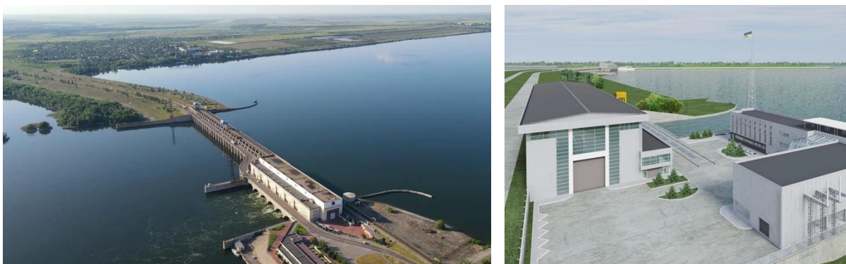
Fot.5 Po lewej: Zapora Kachowska wraz z EW Kachowska I przed zniszczeniem. Po prawej: widok od strony projektowanej EW Kachowska II po planowanej odbudowie stopnia wodnego (Ukrhydroprojekt, 2022)
